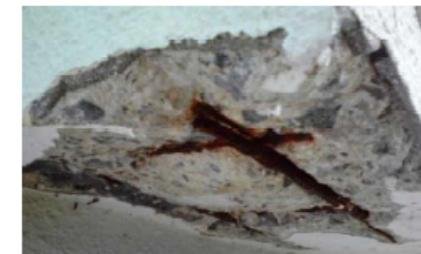
内部の鉄筋腐食状態
