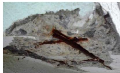
内部の鉄筋腐食状態
