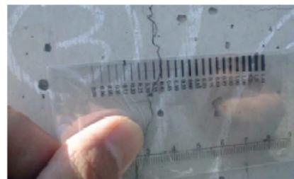
目視点検 (ひび割れ幅の計測)
