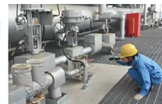
目視検査の様子
