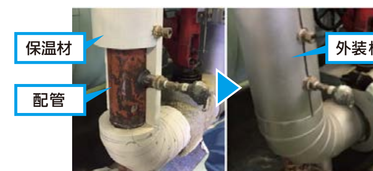
配管の被覆状態（例）
