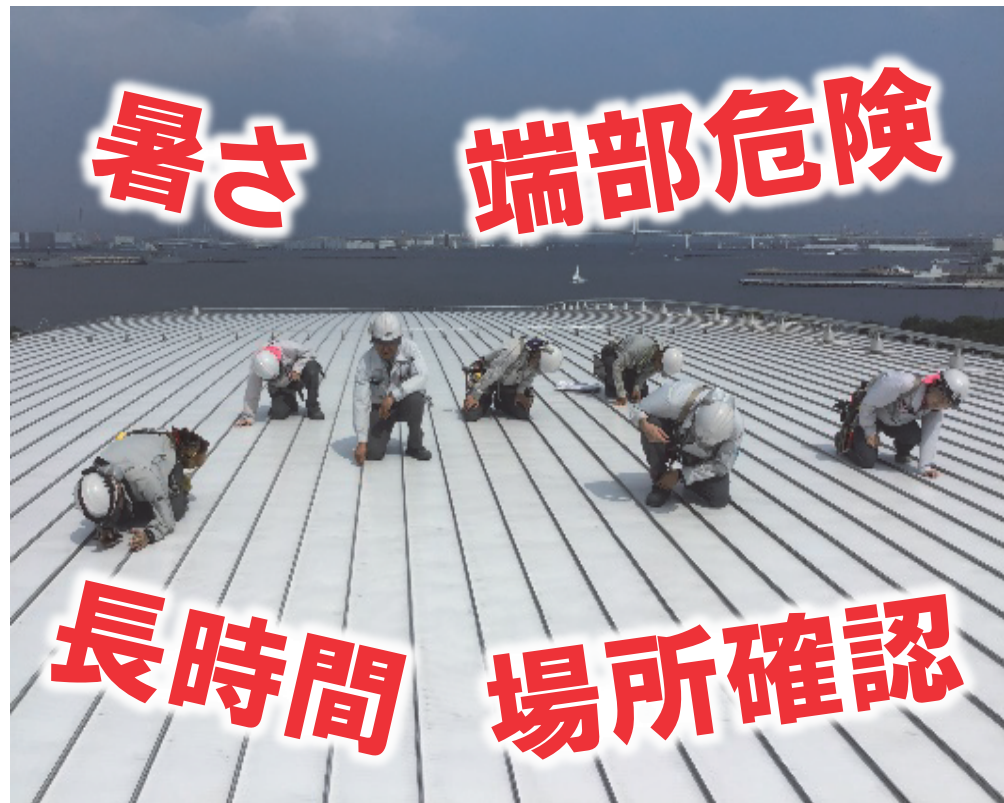
現地目視調査
