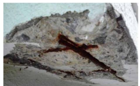
内部の鉄筋腐食状態
